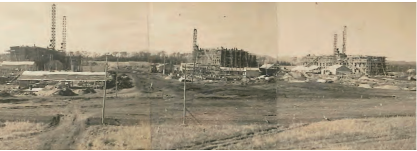
ボイラーの据付時代 保安隊(昭和 27 年)
