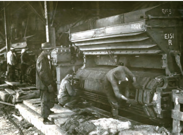
樺太でのボイラー据付
