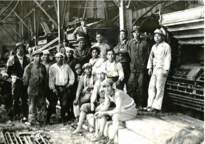
樺太でのボイラー据付時代
