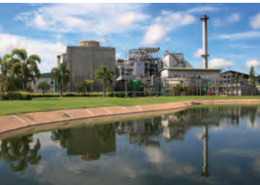
10MW発電所 全景
