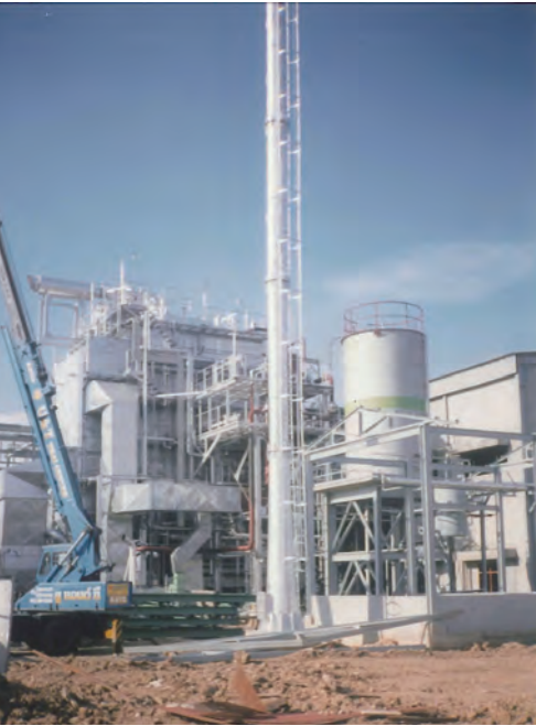
H-900型コーン粕焚きボイラー建設中
