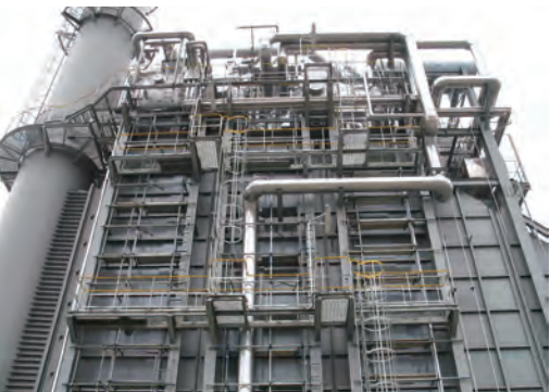
建設中のHRSG-26000型
