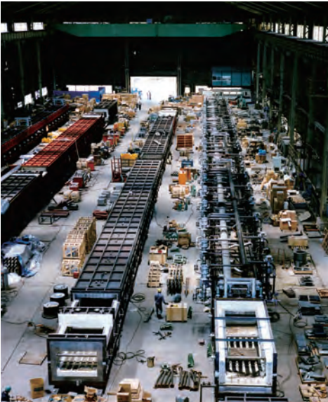
組立中の連続焼鈍炉(拡張期)
