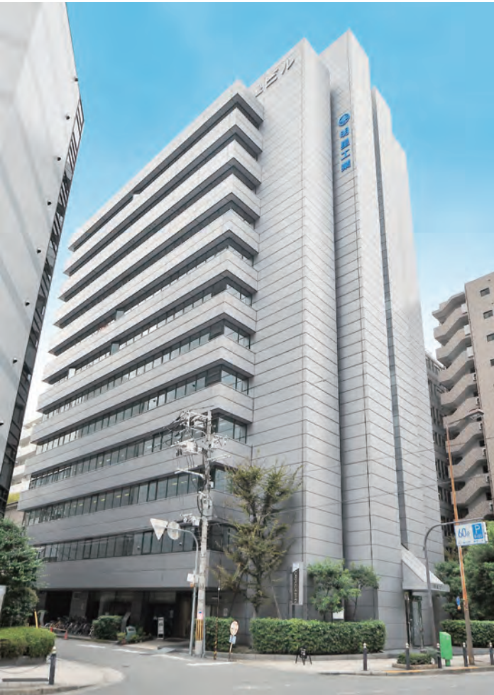
明星工業(株)本社ビル
