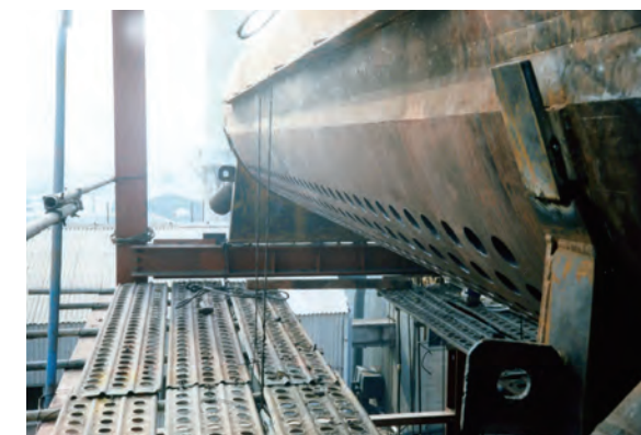
据付けされた上ドラム TAESUNG LUMBER
