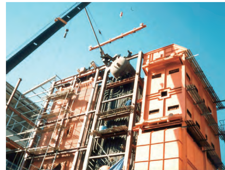
建設中のH-1500型 TAESUNG LUMBER
