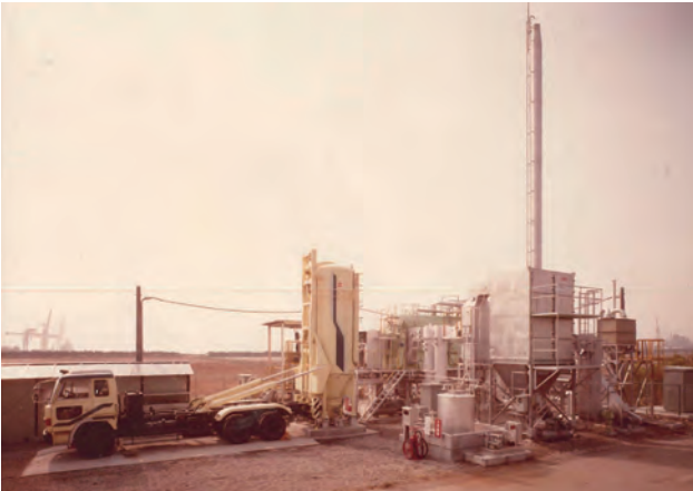
中小企業事業団のカートリッジ微粉炭焚きボイラー燃焼試験 (日本鋼管(株)福山製鉄所)
