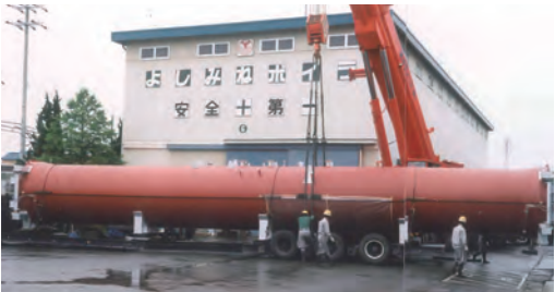
増築されたプレス棟から出荷されるオートクレープ(昭和58年)
