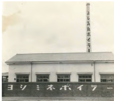
高洲の事務所兼工場
