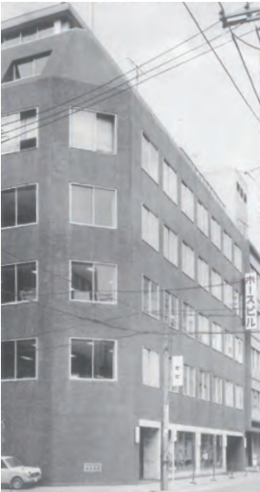
本社(ホースビル)
